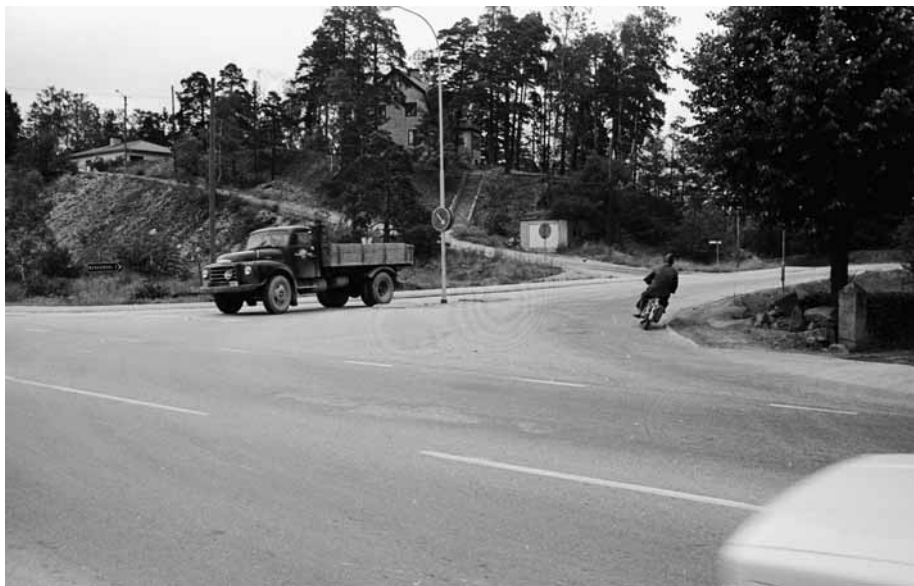
Infart till Landsnoravägen från Sollentunavägen, med dåvarande Platåvägen, som går upp på åsen. Augusti 1971
