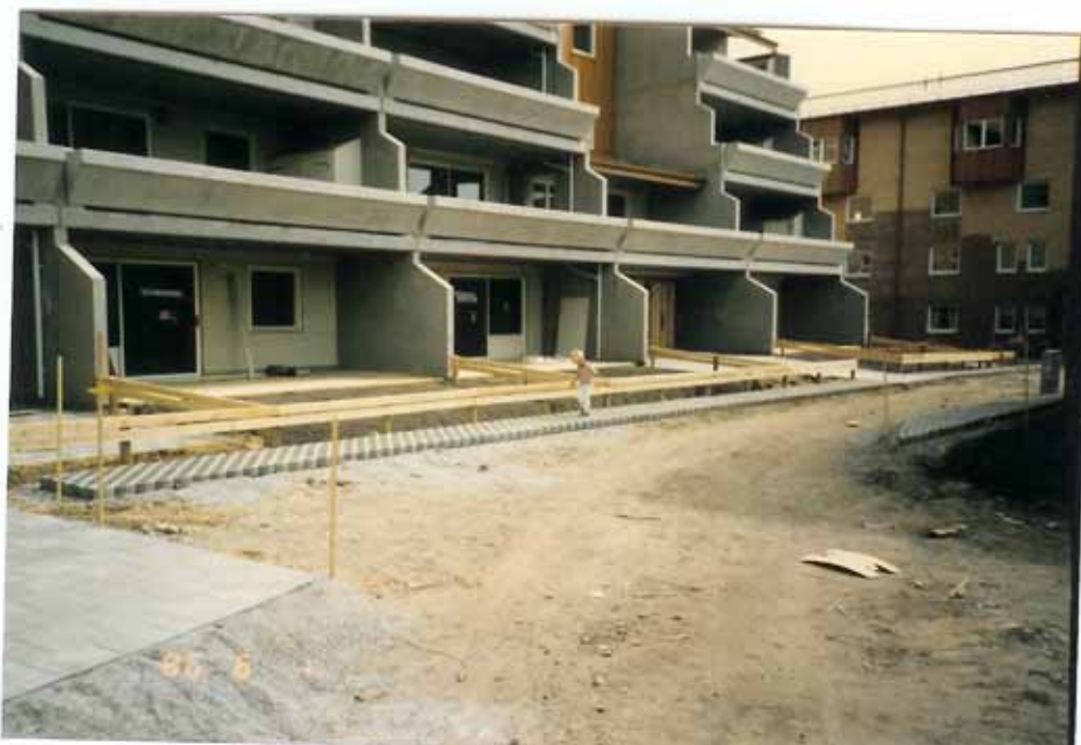
B-huset under byggnationen, motsvarar rätt väl även tidigare Platåvägen 6
