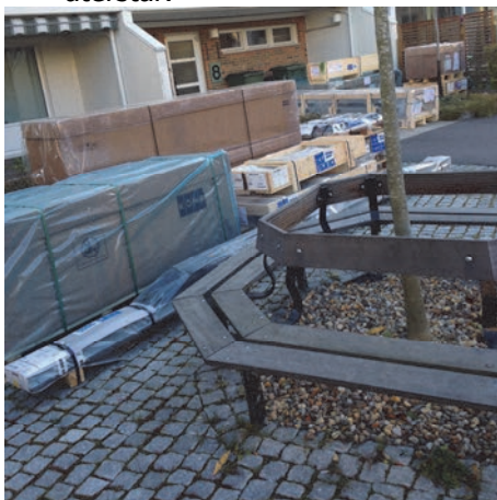
Lagring av hissmaterial fick ske utomhus för port 6 och 8.
